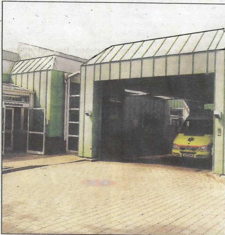
Verdoppeln wird das Klinikum die Kapazitäten in der neuen Notaufnahme. Baubeginn ist im September. Foto: Michael Hehmann
